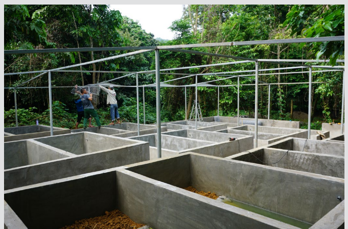
Khu chuồng nuôi mới của loài rùa đầu to đang dần vào giai đoạn hoàn thiện và sẽ hoàn thành vào tháng 9 năm 2021 sau khi hệ thống thoát nước và bể xử lý nước thải được xây dựng. © Nguyễn Thu Thủy – ATP/IMC
